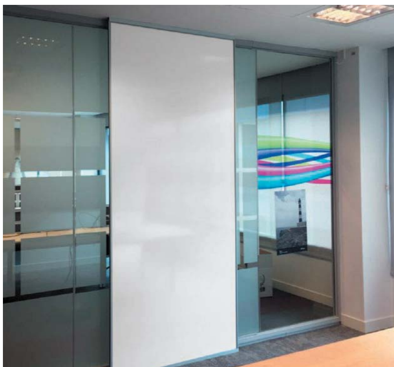
Pizarra acero vitrificado blanco, fijada a techo y suelo hecha para ocultar las puertas de cristal cuando se abren.
